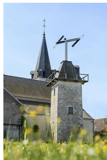
La station Chappe de Baccon dans le Loiret, sur la ligne Chappe Paris-Bayonne, restaurée en 2003.
